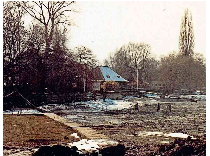
Die Sanierung Seegartenscheune mit Hafenmeisterbüro und sanitären Anlagen gehörte auch zum Projekt.
