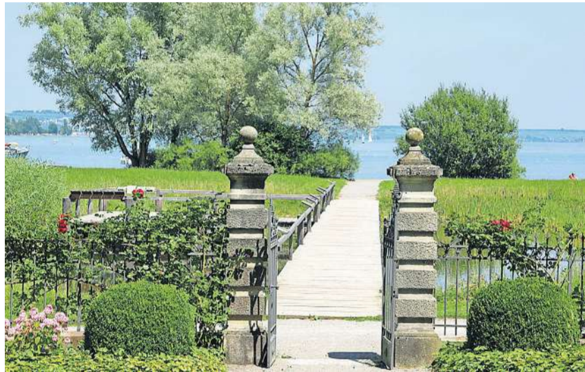
Der Steg über dem Amphibienweiher ist mittlerweile morsch und derzeit gesperrt. Im Zuge der Pflegearbeiten wird er ersetzt.
