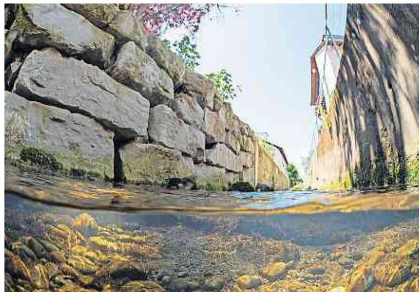
Am Saubach entlang der Konstanzerstrasse wurde der Kanal im Jahr 2016 ökologisch aufgewertet und hochwassersicher gemacht.
