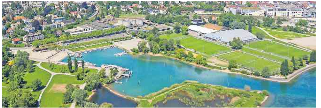
Entlang des Seewegs am rechten Bildrand, entsteht der provisorische Weg.
