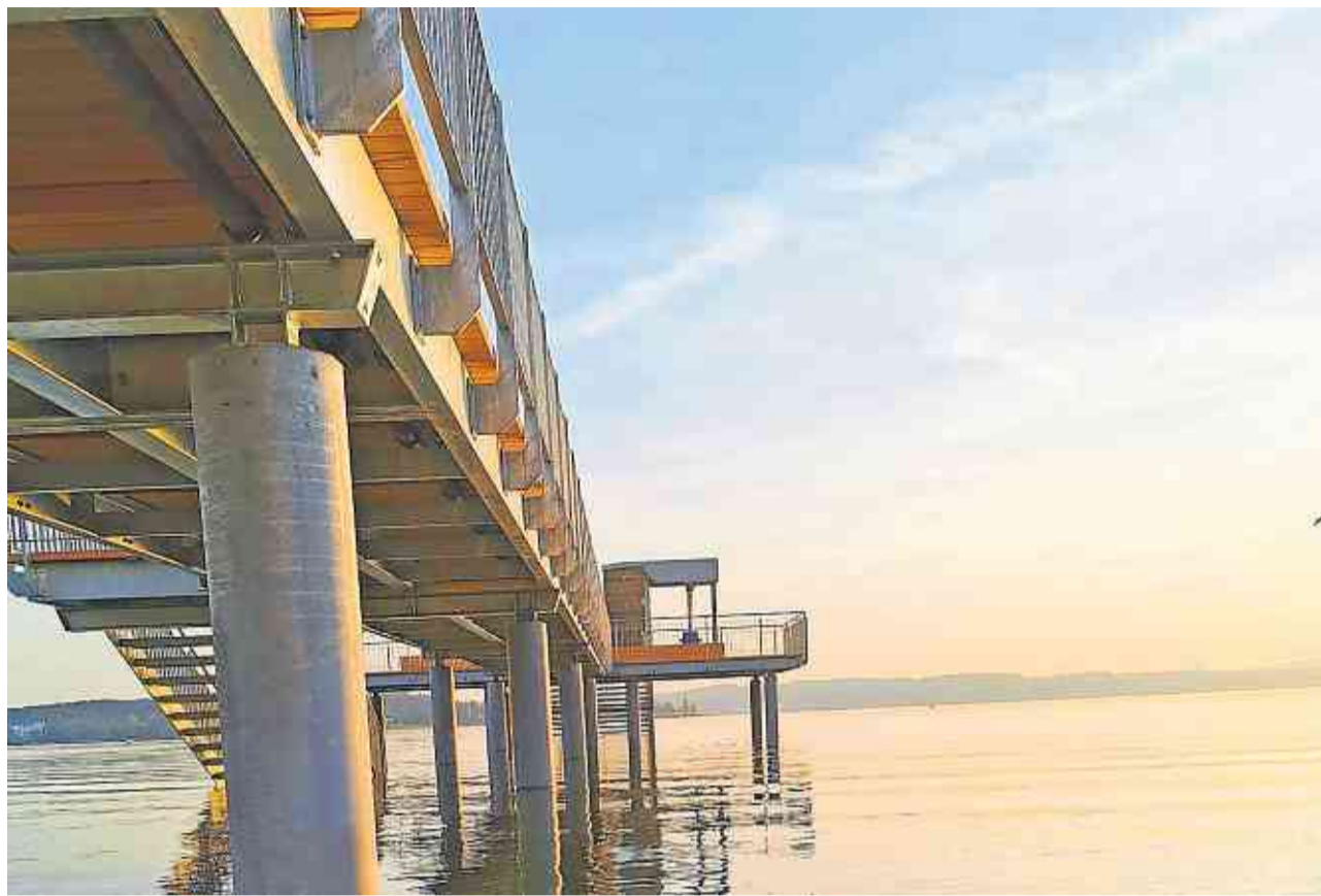
Rechtzeitig zur Badesaison ist der neue Badesteg fertig.
