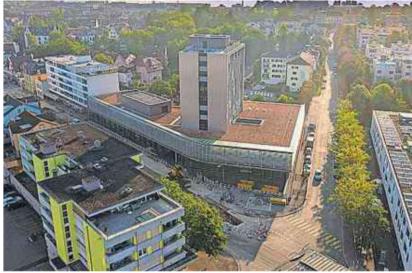
Mit der neuen Bauetappe erfolgt die Umleitung der Stadtbuslinie 903.
