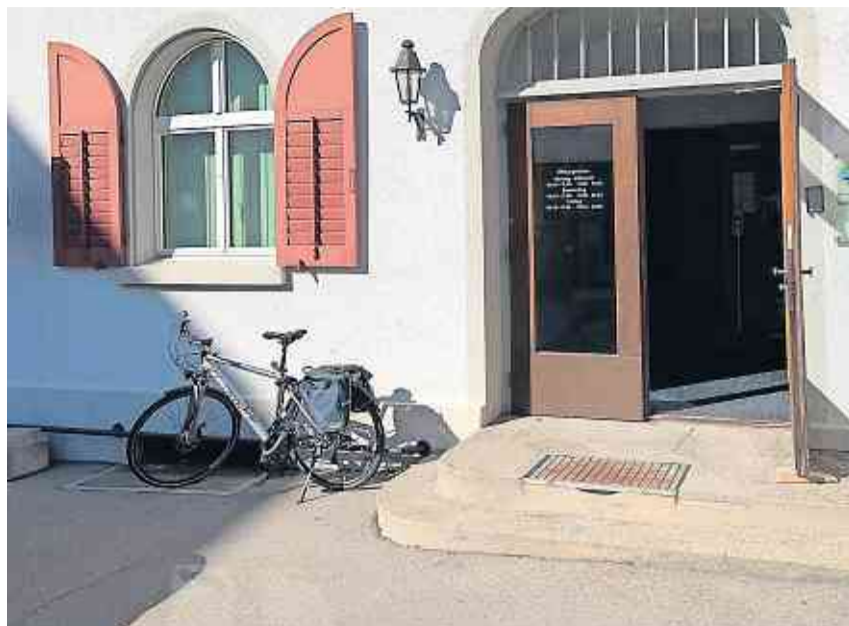
Der Eingang an der Marktstrasse wird barrierefrei und bleibt vom 7. bis 21. Oktober geschlossen. IDSK
