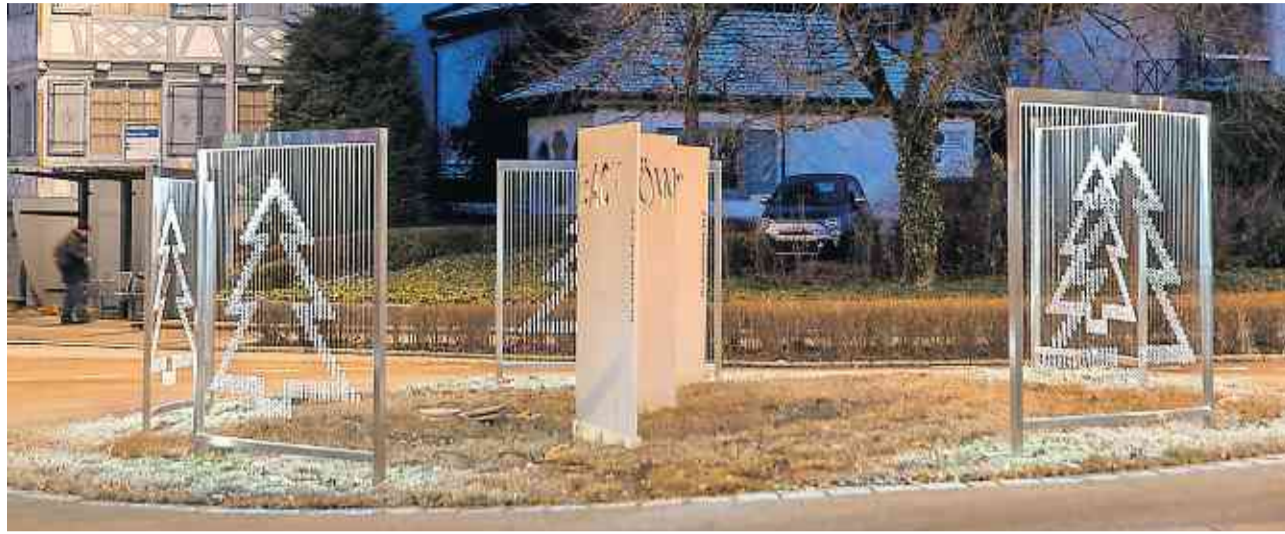
Mehrheitlich ist die Adventsbeleuchtung in Kreuzlingen bereits heute mit energiesparender LED-Technik ausgestattet.
