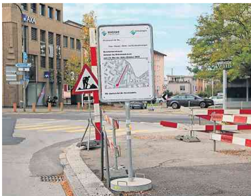
Bis März 2023 gilt in der Brückenstrasse eine Einbahnregelung.
