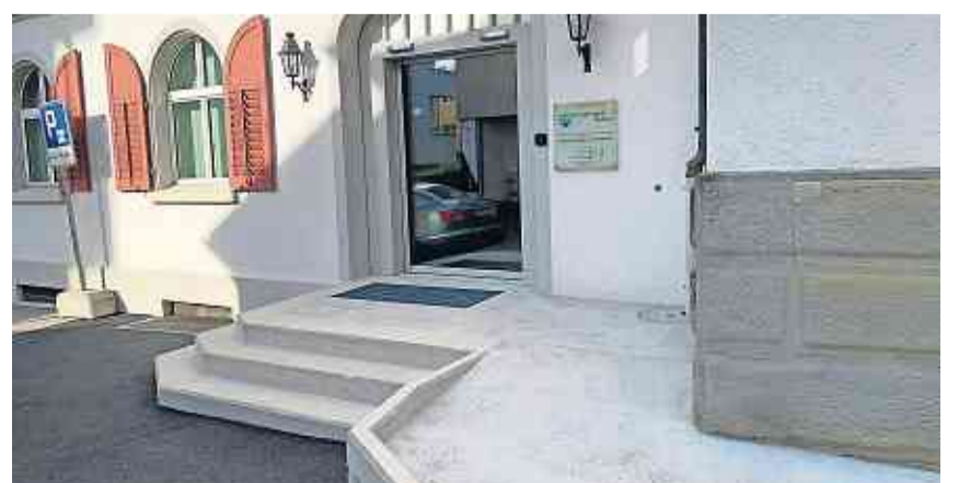
Der Zugang zum Stadthaus Marktstrasse ist neu barrierefrei. IDSK
