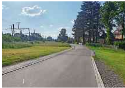
Am Montag starten die Bauarbeiten. IDSK
