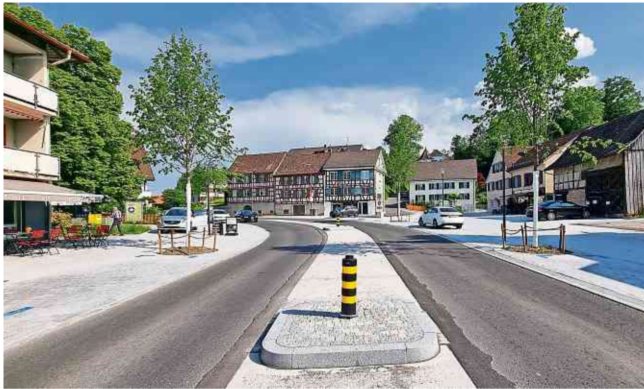
Unter Vollsperrung wird der Deckbelag zwischen dem 10. Juli und 15. Juli eingebaut.
