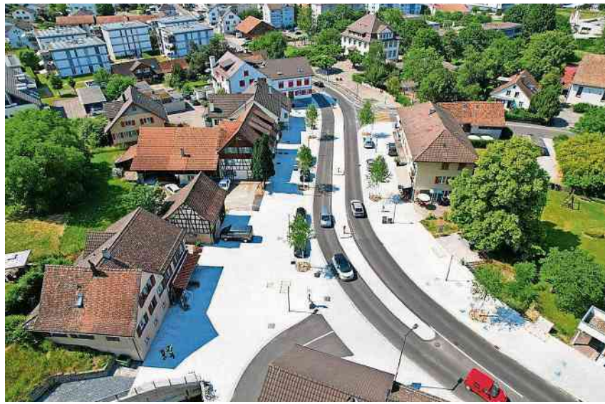
Am 30. September wird das umfangreiche Bauprojekt der Romshornerstrasse mit einem Einweihungsfest gefeiert. IDSK
