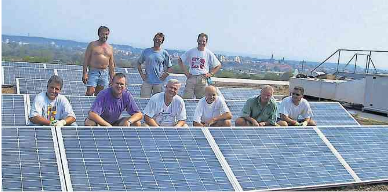
Das Team nach dem Installieren der ersten vereinseigenen PV-Anlage 2003.
