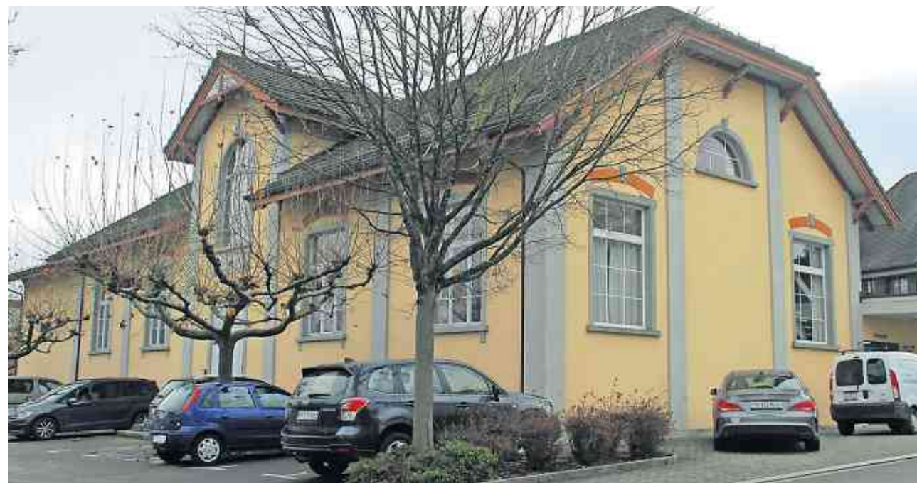
In der Bürgerhalle stehen Sanierungen und mögliche Umnutzungen an.
