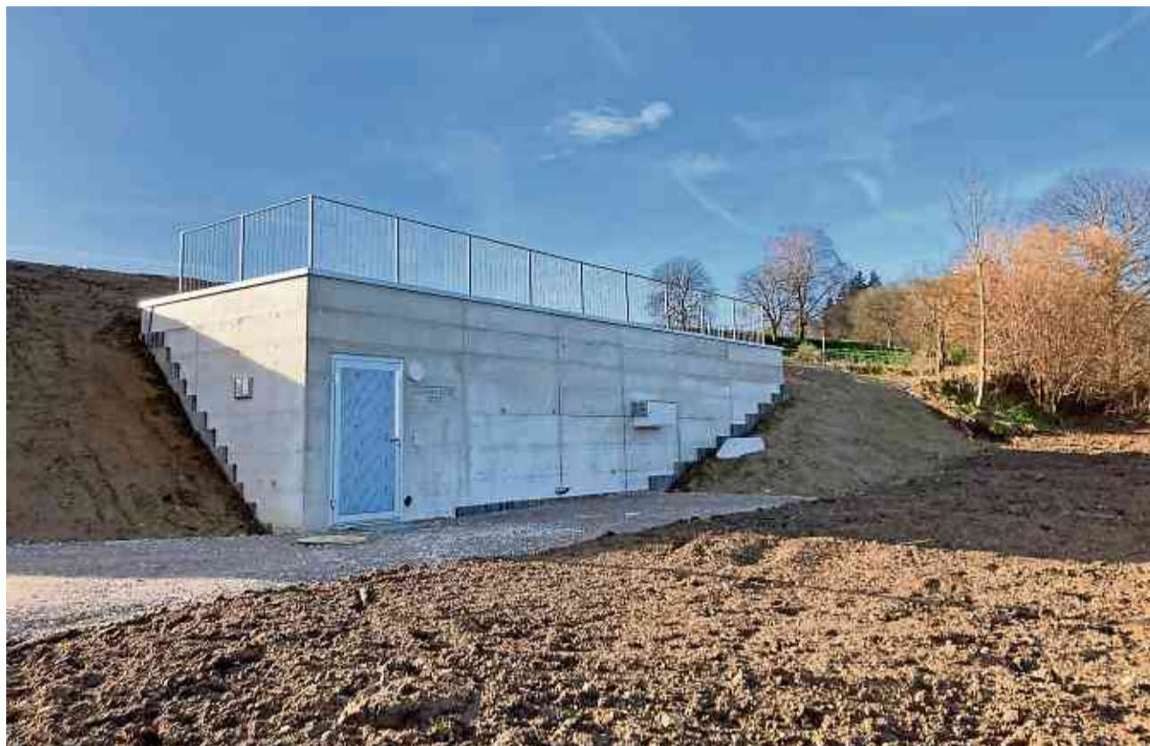
Vergleichbar mit einem Eisberg: Vom Ersatzneubau des Wasserreservoirs Gruebhalde ist nur ein kleiner Teil sichtbar.
