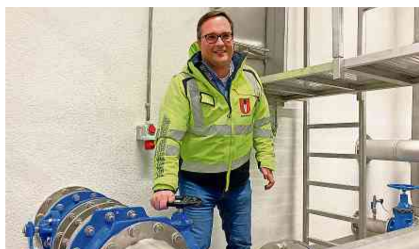
Das neue Reservoir Gruebhalde hat den Betrieb aufgenommen.
