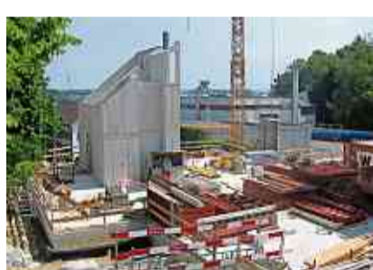
Bauzustand des Kirchgemeindehauses.
