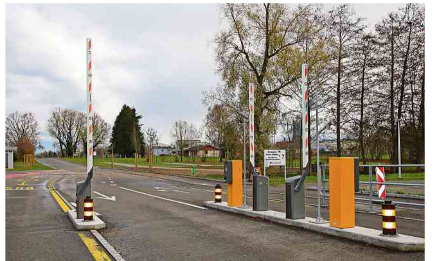
Die Schrankenanlage beim Schwimmbad Hörnli wird diesen Monat zurückgebaut.
