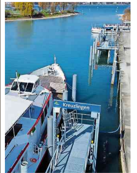
Die neue Steganlage.
